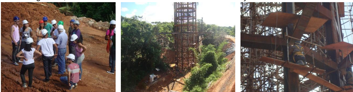
Figuras 6, 7 e 8: Visita dos alunos de Materiais de Construção à obra do TRT-5.
