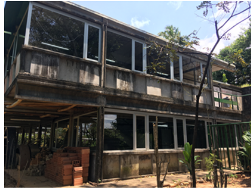
Figura 3 - Vista do Módulo Iansã
